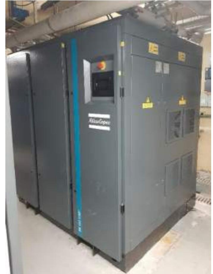
*Remplacement du compresseur d'air comprimé*
